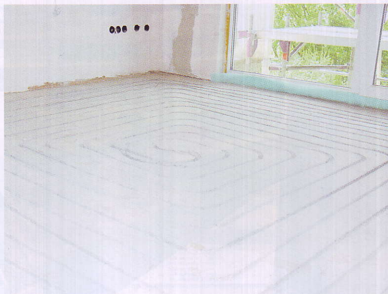
Für die Fußbodenheizung im Erdgeschoss wurde ein spezielles Verfahren angewandt, bei dem maschinell Kanäle in den bestehenden Estrich geätzt werden, in die anschließend die Heizungsrohre eingelegt werden
