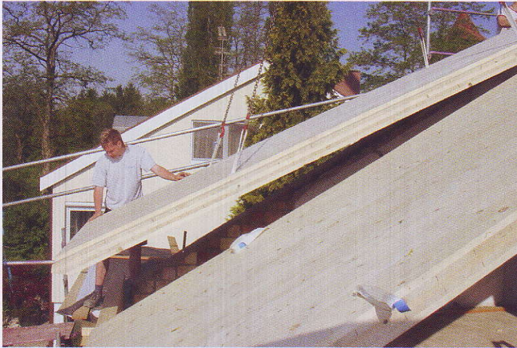
Die Brett-Sperrholz-Dachelemente bildeten eine geschlossene Dachfläche. Die Dämmung wurde vollflächig als Aufdachdämmung verlegt
