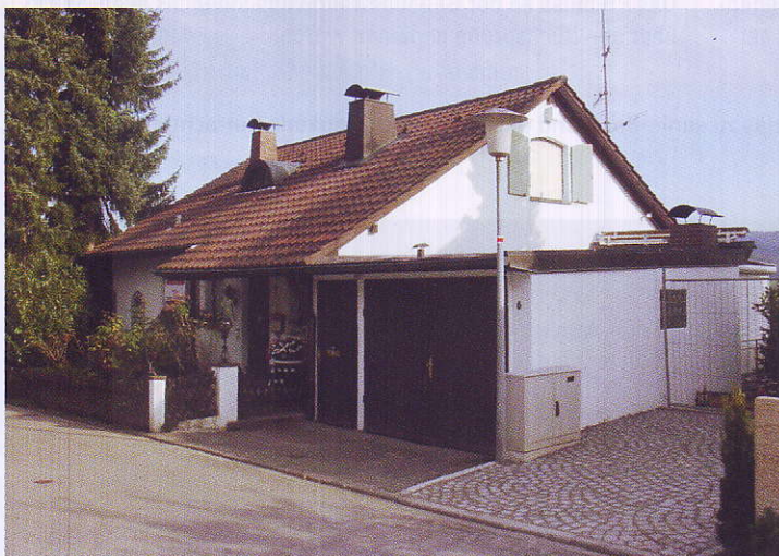
Vor der Sanierung: Ein Altbauhaus Baujahr 1965 als Energieschleuder mit veralteter Ölheizung
